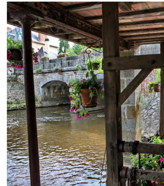
**LE LAVOIR DU MOULIN** Grand lavoir communal installé au pied de l'un des deux anciens moulins à blé. Grâce à un système de réglage adoptant le principe des ponts-levis, l'élévation verticale du plancher permettait l'utilisation du lavoir en période de crues au pied du pont.
